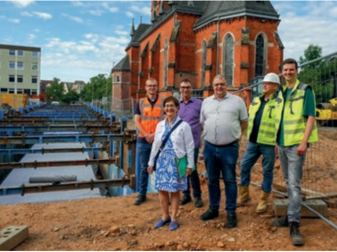
Über den Stand der Bauarbeiten an der Rigole informierten sich (v. l. n. r.): Mirco Hofmann von Bickhardt Bau, Bürgermeisterin Anke Hofmann, ProjektStadt-Projektleiter Jörg Albin, Johannes van Horrick, Fachbereichsleiter Technische Verwaltung der Stadt Bad Hersfeld, Joachim Oster und Leon Daum von aqua geo consult.
