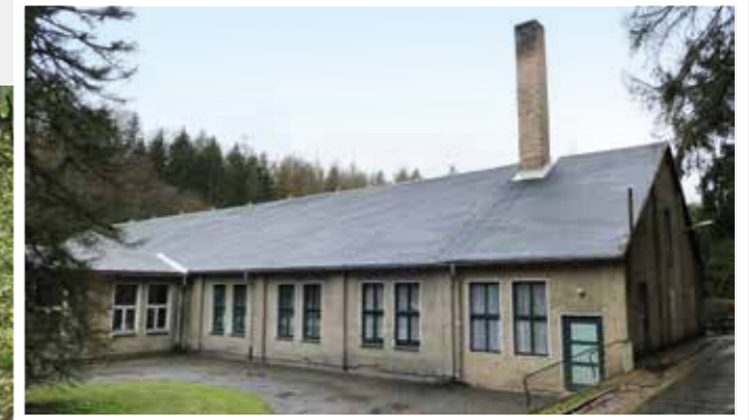
An vielen Stellen besteht dringender Sanierungsbedarf, auch strukturelle und infrastrukturelle Defizite sind vorhanden.
