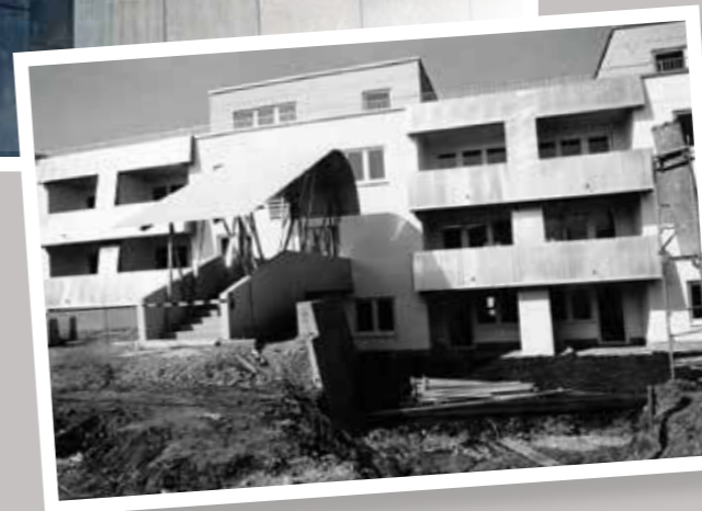
Die Goldstein-Siedlung: 162 Sozialwohnungen in einem für die damalige Zeit futuristisch anmutenden Look, dank Zink-Einhausung der Gebäude.
